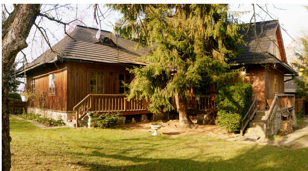
Fot. nr 2 – budynek dworku – widok od tyłu
