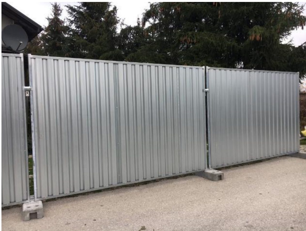
Fot. nr 5 - Poglądowe zdjęcie ogrodzenia tymczasowego
