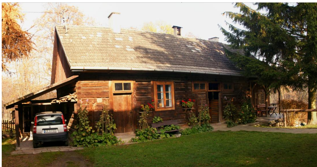
Fot. nr 3 – budynek gospodarczy – widok ogólny
